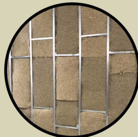
CONTROPARETI ISOLANTI - CAPPOTTO INTERNO ISOLANTE PER TRAMEZZI A SECCO
