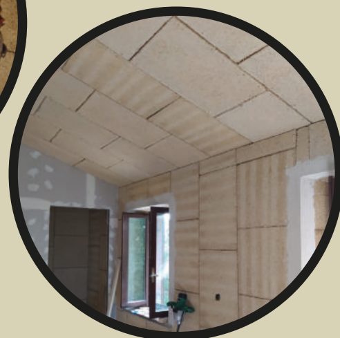
CONTROPARETI ISOLANTI A SECCO - CAPPOTTI INTERNI - TRAMEZZI
