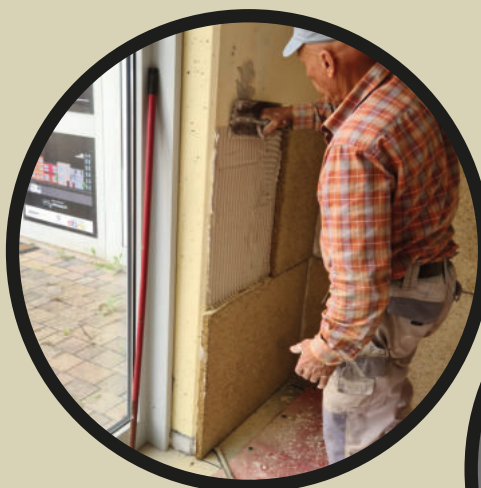
PLACCAGGIO ANTI UMIDITÀ DI RISALITA
