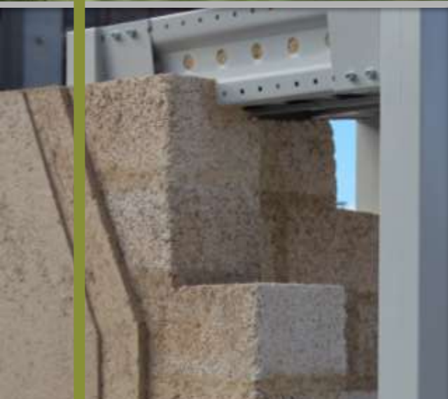
Sistema modulare Casa Hi-low Casa Passiva Mediterranea prefabbricata in Muratura Vegetale di Biomattone in Canapa e Calce; modulare
