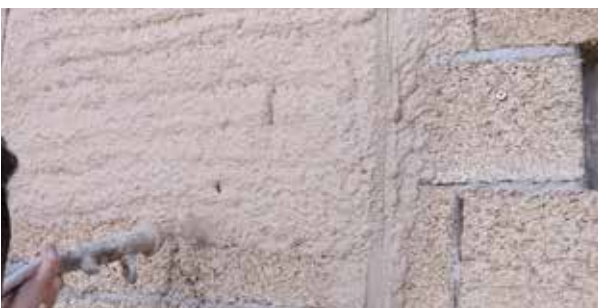
APPLICAZIONE A MACCHINA
