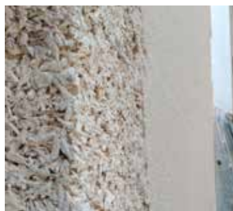
OPERAZIONE DI STAGGIATURA
