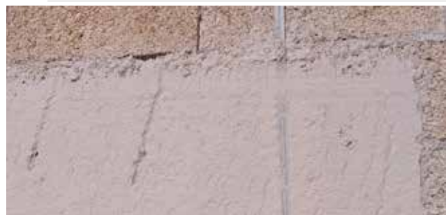
ASPETTO PRIMA MANO DI INTONACO
