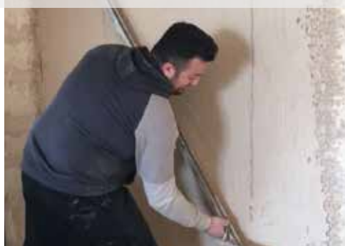
OPERAZIONE DI STAGGIATURA
